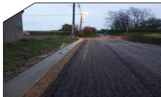
Rénovation des branchements d'eau potable sur Nielles
