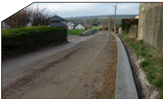
Travaux en cours Rue d'Enguinegatte
