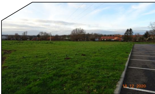
Nivellement du terrain D'agrément près du nouveau parking
